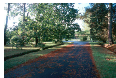
voirie et fossés latéraux
