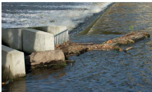
Figure 7 : Encombrement d'une entrée hydraulique (à gauche) et d'une échancrure interbassins (à droite)
