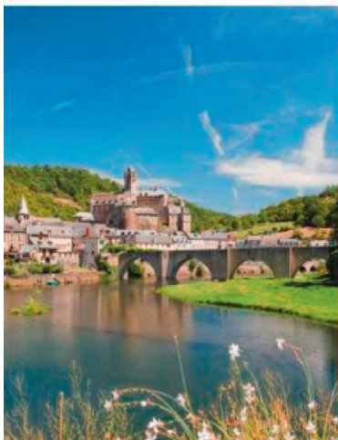
Commune d'Estaing dans l'Aveyron, éligible au Programme national Ponts
