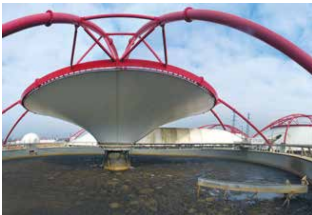
Plusieurs stations d'épuration intègrent désormais un méthaniseur au sein de leur site afin de valoriser leurs boues d'épuration.
