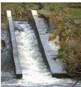
Photographie 16 : Passe à ralentisseurs de fond suractifs en Normandie (GHAAPPE)
