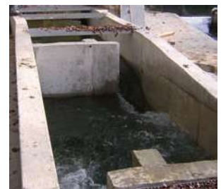
Photographie 7 : Pont de Beauvoisin (73) barrage Cholat - rivière Guiers (GEI/SIEE)
