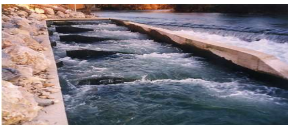
Photographie 11 : Passe à seuils déversants et fentes verticales - Bédarrides (84) - rivière Sorgues (GEI/SIEE)
