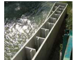
Photographie 6 : Passe à échancrures latérales. Pont de Beauvoisin (73) barrage la Baronnie - rivière Guiers (GEI/SIEE)
