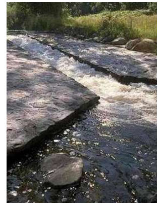
Photographie 14 : Passe à ralentisseurs Moulin Neuf (22) - rivière Trieux (GHAAPPE)
