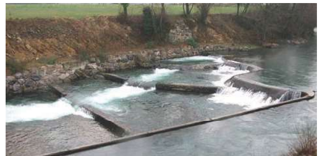
Photographie 13 : Prébarrages Gurmençon (64) - rivière Gave d'Aspe (GHAAPPE)
