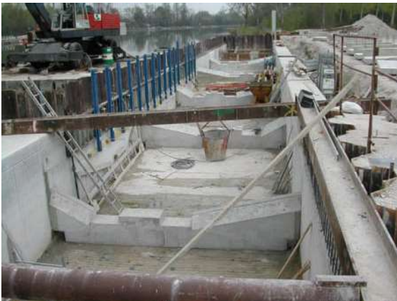
Photographie 10 : Passe à seuils déversants et échancrures Jaulnes (77) - rivière Seine (GEI/SIEE)
