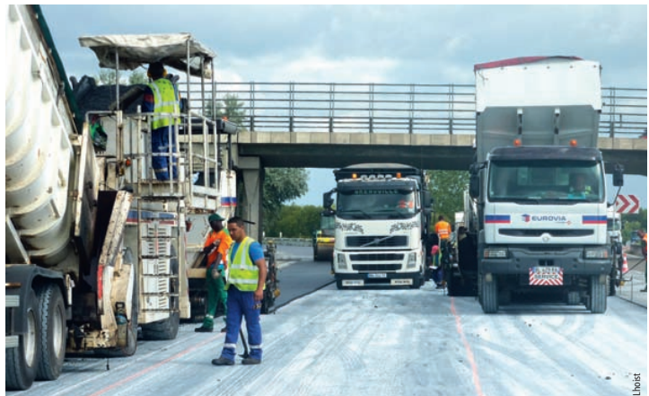
L'épandage de lait de chaux Asphacal TC protège les couches d'accrochage vis-à-vis du trafic des engins et limite les salissures aux abords des chantiers Spreading of Asphacal TC lime milk protects pavement tack coats from construction traffic and limits the soiling of worksite areas
