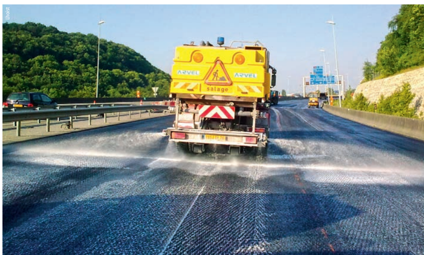
Photo 2 Epandage de lait de chaux dilué Spreading of diluted lime milk
