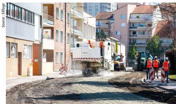
Chantier Recyclean® dans un quartier résidentiel de Roanne
