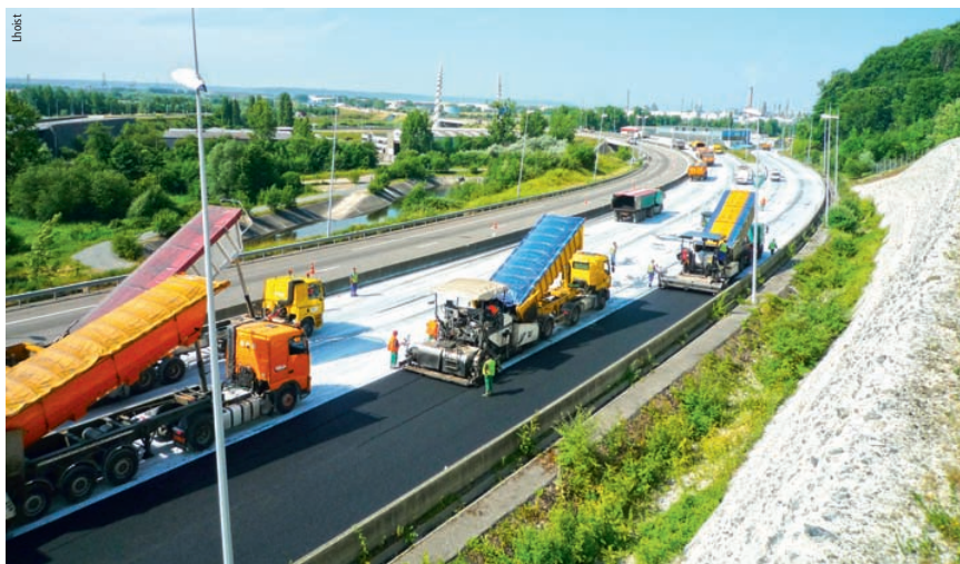
Photo 1 Mise en œuvre d'enrobés sur l'autoroute A29 en France avec couche de collage traitée au lait de chaux Laydown of asphalt on French motorway A29 with lime-milk treated tack coat
